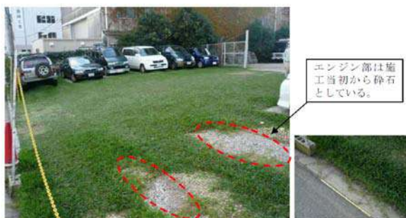
維持管理を丁寧に行うことで良好な芝生を保っており、エンジン部は砕石としています。（プラスチックマット補強型）
