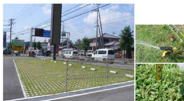
維持管理を十分に行うことで良好な芝生を保っています。（コンクリートブロック補強型）
