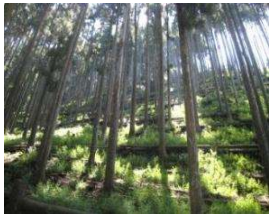
緊急防災林整備 (間伐木を利用した 土留工の設置)
