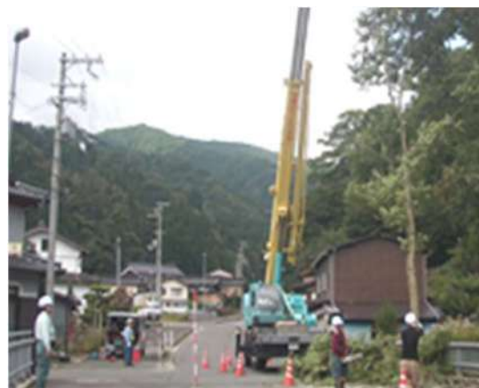
里山防災林整備 (人家裏山の危険木伐採)
